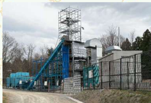
須賀川バイオマス発電所発電設備
