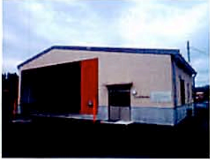
木材団地事務所
